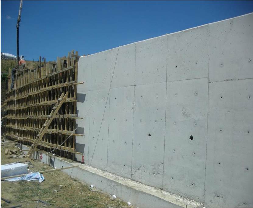
Şekil 4. Betonarme istinat duvarına ait bir görsel.
