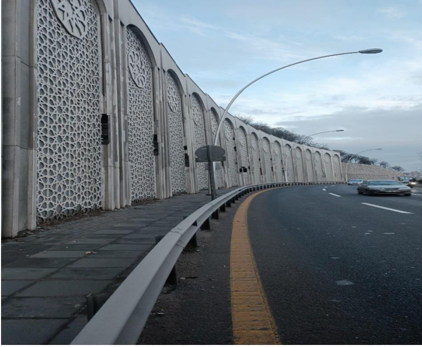
Şekil 3. Ankara/Keçiören’de istinat duvarı üzerine yapılan süslemelere ait görsel.
