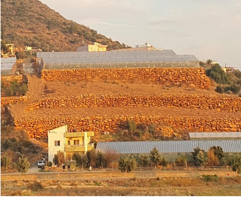
Şekil 1. Mersin/Aydıncık’da harçsız istinat duvarlarına ait görsel.
