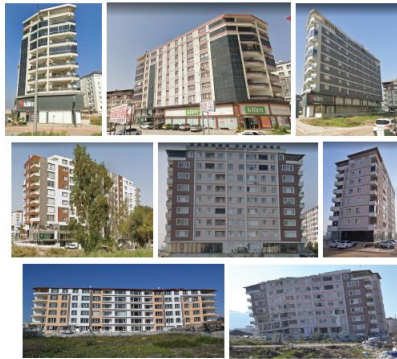
Şekil 17. Planda ince ve uzun izdüşüme sahip yıkılan ve hasar gören binalar (Korkmaz,2023)
