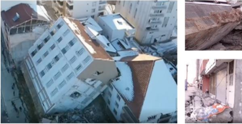
Şekil 18 - Adıyaman ilinde yerel zemin koşullarına bağlı ortaya çıkan hasar ve oturmalar(Anadolu Ajansı) (Korkmaz,2023)
