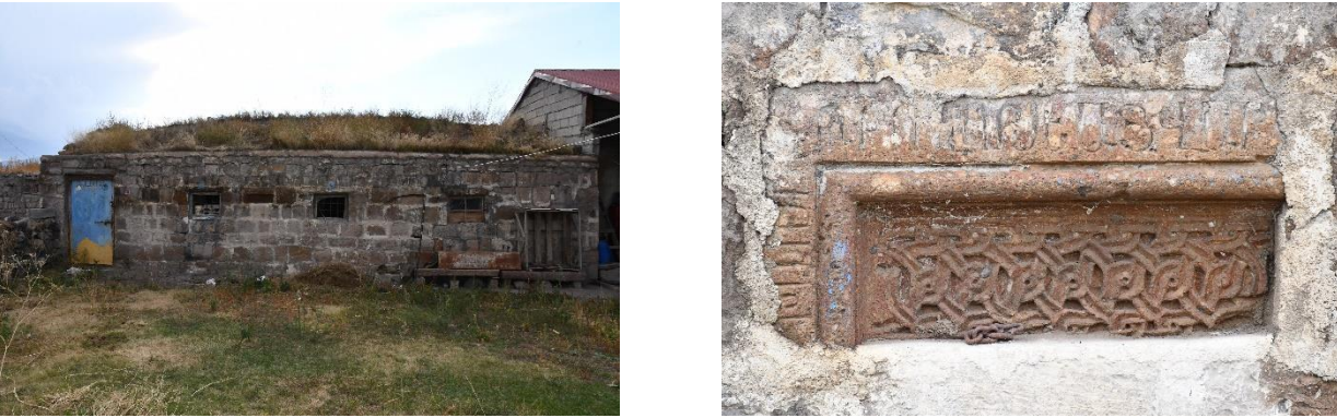
Görsel 35: Bergüzar Şengül Evi Cephesi ve Detayı
