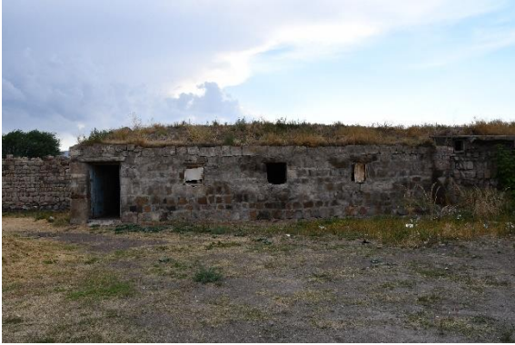
Görsel 21: Yunus Görünmez Evi Ahır Cephesi
