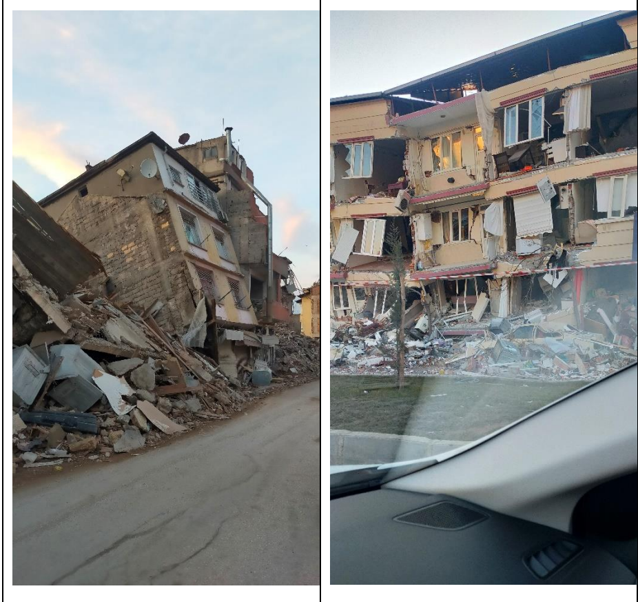
Şekil 2. 6 Şubat 2023 Kahramanmaraş Depremleri; Hatay (solda, 20.03.2023) ve Kahramanmaraş (sağda, 12.02.2023) illerinden görünüm (Ali Rahmi KAYA arşivinden)
