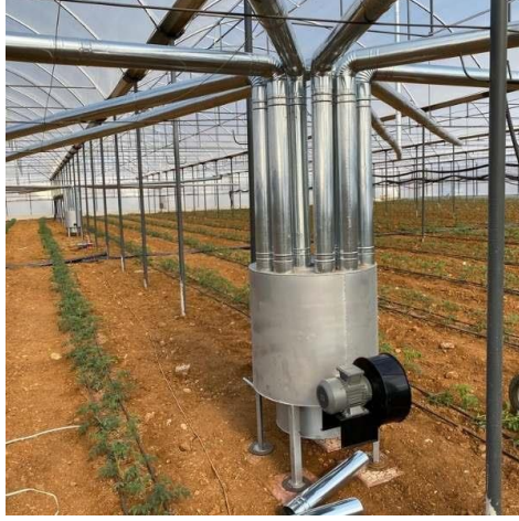
Şekil 1 Büyük seralarda kullanılan soba (Anonim 1, 2024)
