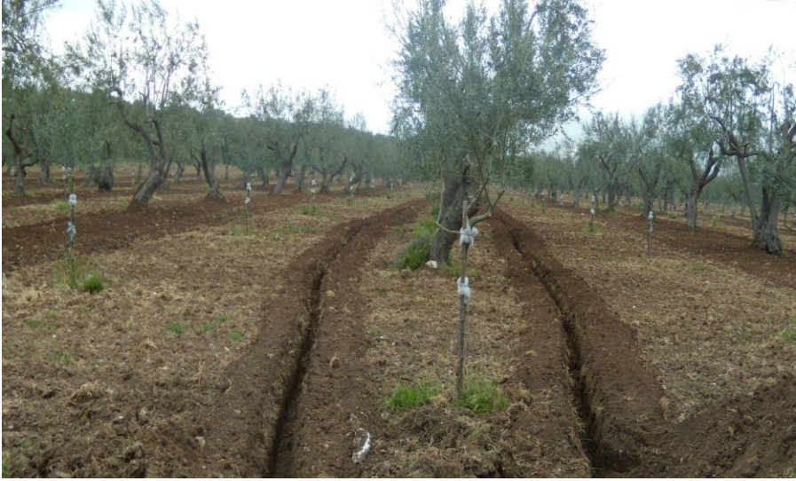
Şekil 2. Toprakaltı damla sulama sistemi (Kösetürkmen, 2020)
