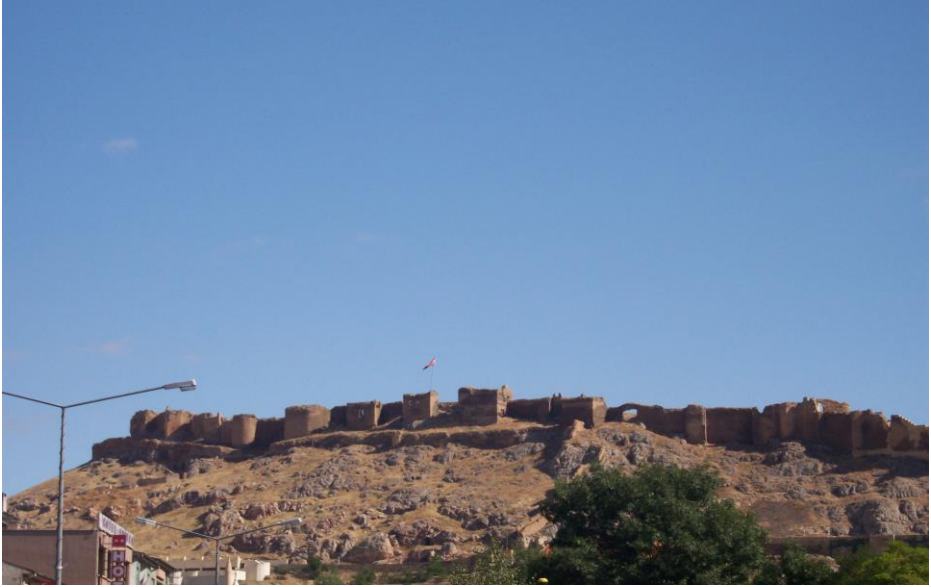
Bayburt Kalesi Genel Görünüm
