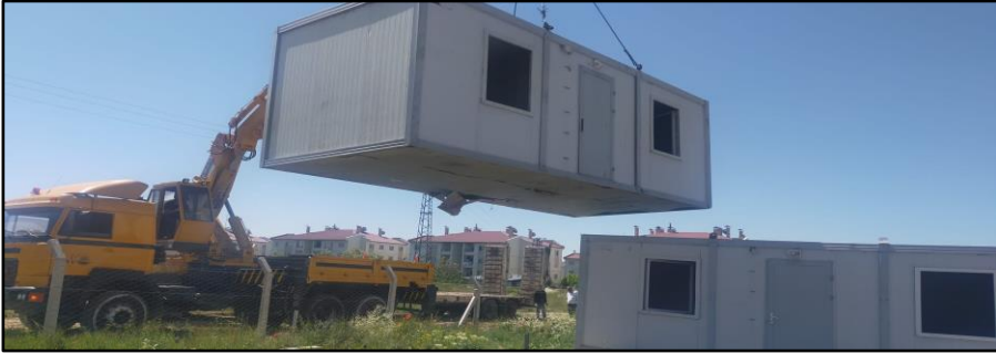
Şekil 6: İklim Odası ve işletme binası olarak kullanılan konteynerlerin kurulum aşaması
