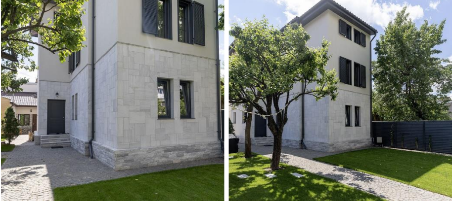
Şekil 4. Doğal taş yüzeylerine çekiçleme (Bush Hammering) uygulanmış bina
