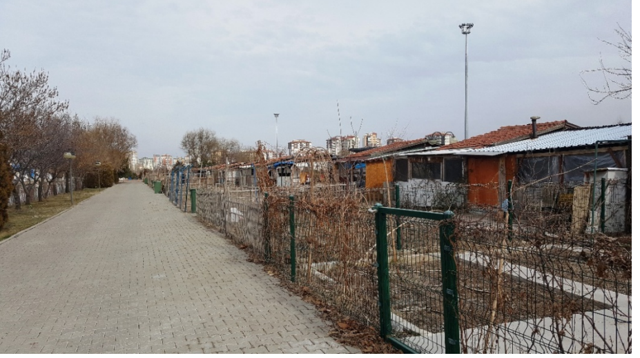
Şekil 2. Alan genelinde farklı malzemelerle yapılmış bütünlük bozan yapısal donatılar
