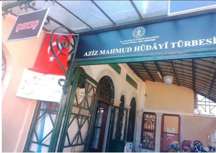
Fot.199, No-30, Üsküdar Aziz Mahmut Hüdai Türbesi, dış görünüm.
