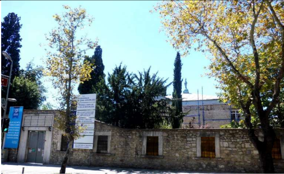
Fot.119, No-18, Üsküdar Küçük Selimiye (Çiçekci) Camisi, dış görünüm
