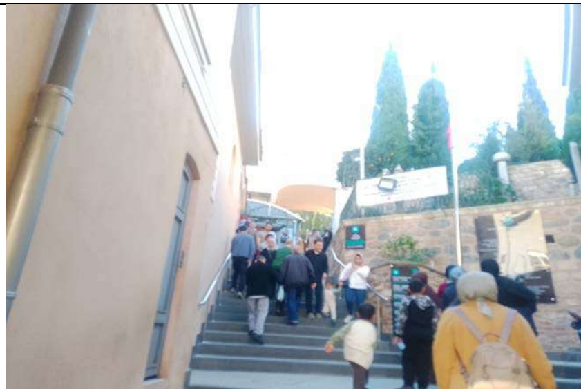
Fot.200, No-30, Üsküdar Aziz Mahmut Hüdai Türbesi, dış görünüm.
