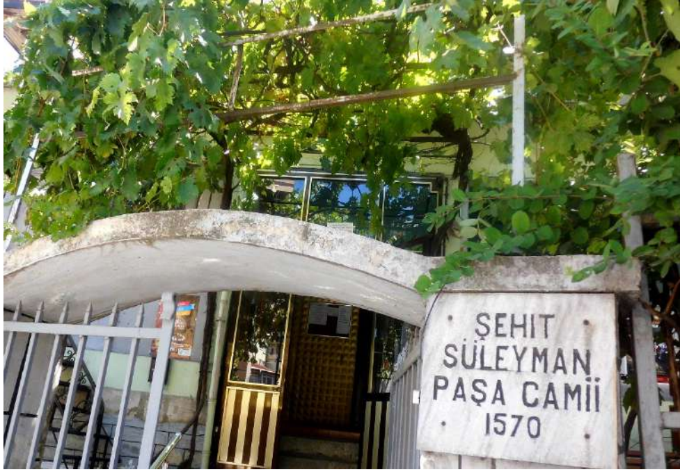
Fot.185, No-28, Şehit Süleyman Paşa Camisi, dış görünüm
