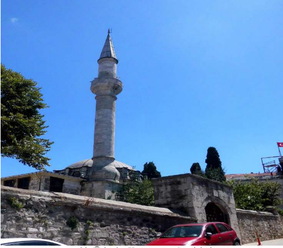
Fot.151, No-23, Üsküdar Kaptanpaşa Camisi, dış görünüm
