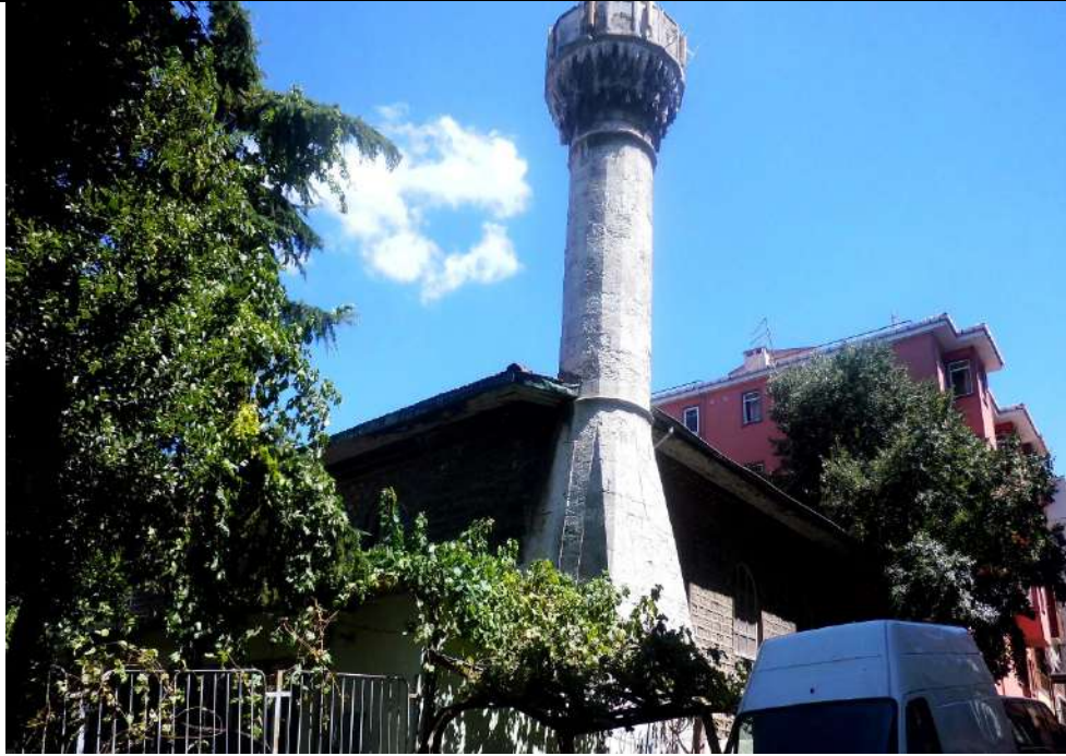
Fot.186, No-28, Şehit Süleyman Paşa Camisi, dış görünüm
