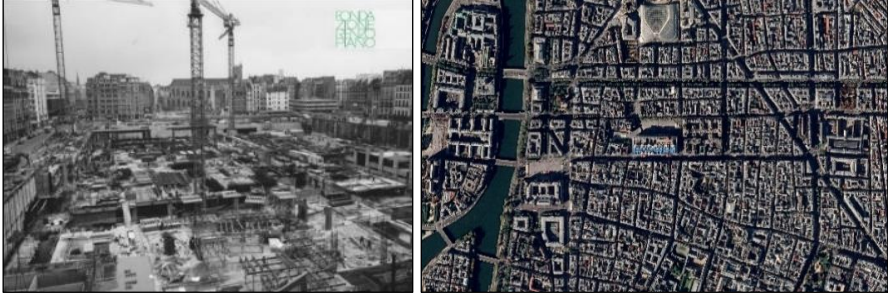
Şekil 6. Pompidou inşaat alanı ve hava fotoğrafı, (Barba, 2021; Piano, 1977).
