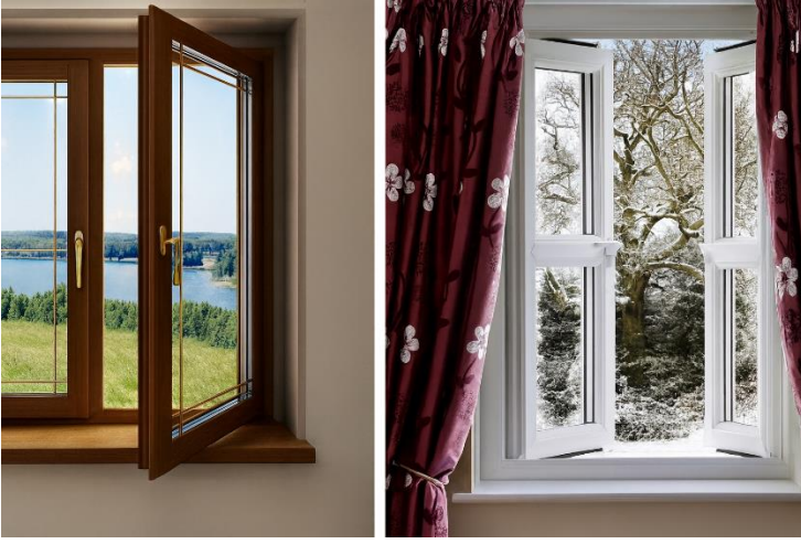
Görsel 26. İçe ve Dışa Doğru Açılan Pencereler (Windows Plastic, t.y.; Colbeck, t.y.).
