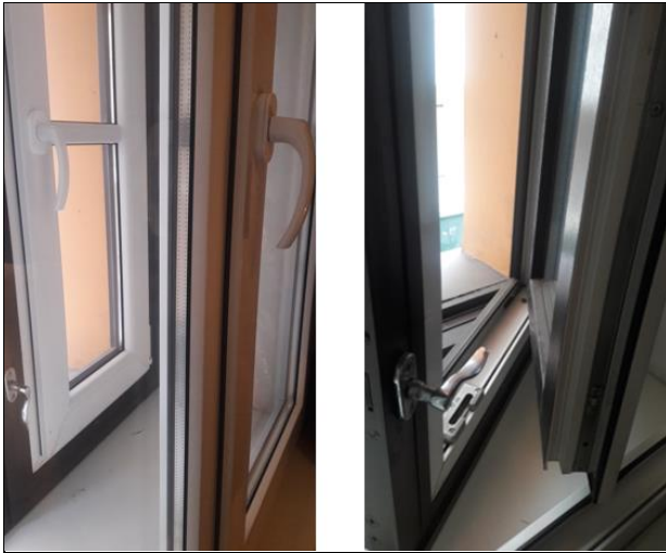
Görsel 13. Bir Çift Doğramalı Pencere Örneği, Letonya ve Bindirme (Muntabık) Doğrama.
