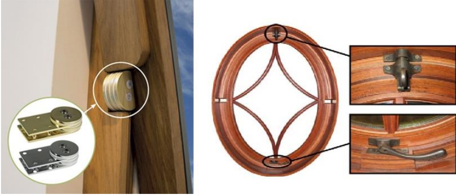
Görsel 203. Eksenli Pencerede Eksen, Kilit ve Kol Örnekleri (Pivot Window,t.y.;The Dawson, t.y.).
