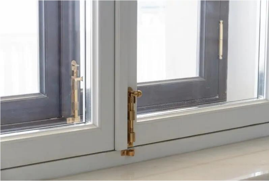
Görsel 139. Pencerede Sürgü (Çift Pencere, t.y.).
