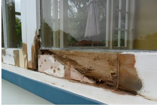
Görsel 117. Ahşap Pencere Doğramasında Çürüme (Window Fix, t.y.).
