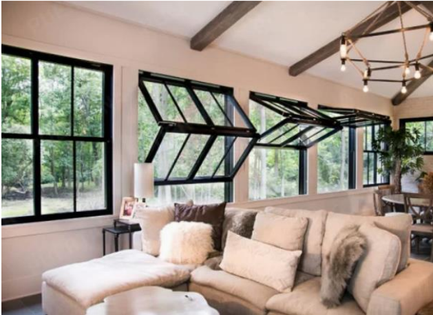
Görsel 221. Yatay Katlanan Pencere Kanatları (Aluminium Bi Fold Window, t.y.).
