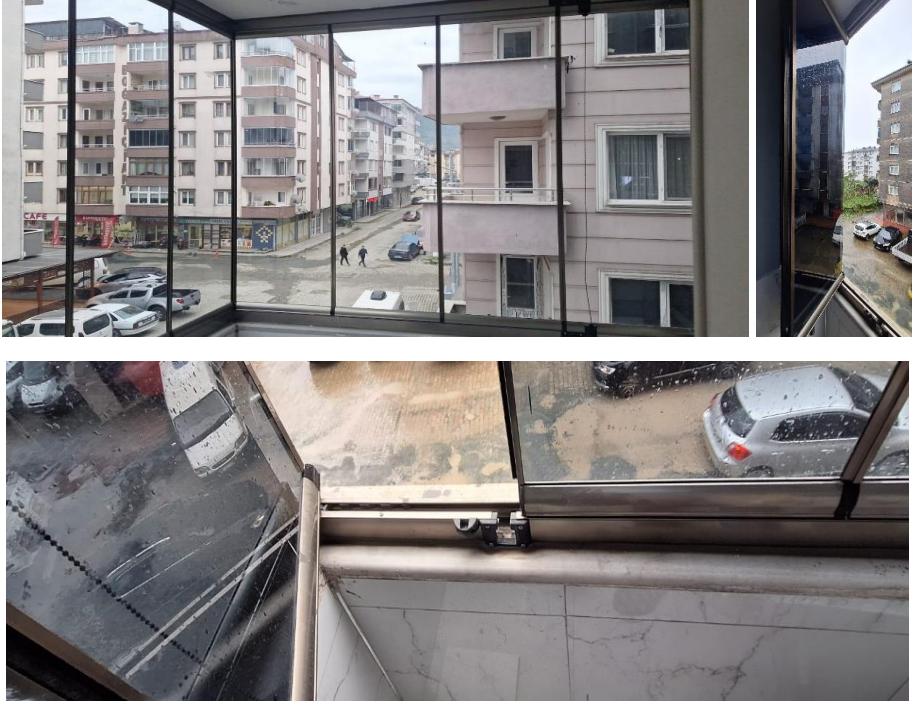
Görsel 335. Katlanır Cam Balkon Sistemi Örneği.
