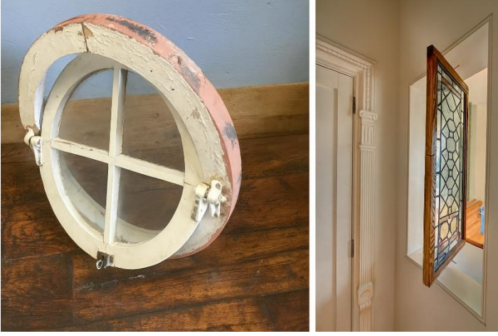
Görsel 202. Eski Bir Yapıdan Çıkma Yuvarlak Bir Yatay Eksenli Pencere (Wooden Round Pivot Window, t.y.) ve İç Mekkânda Düşey Eksenli Pencere (Zillow Learning Center, t.y.).
