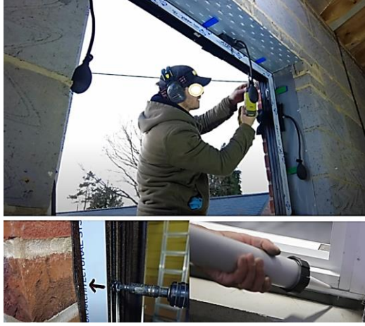
Görsel 294. Alüminyum Profil Doğramanın Montajı (How To Fit An Aluminium Window, 2023).
