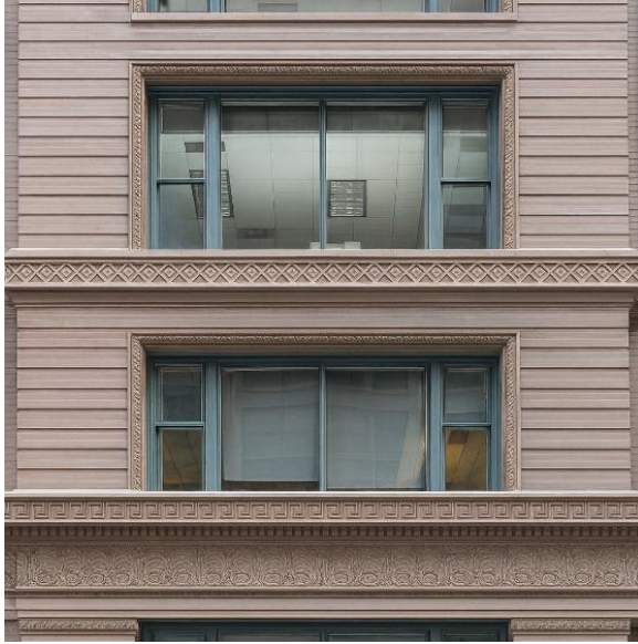
Görsel 58. Şikago Penceresi (Chicago Architecture Center., t.y.).
