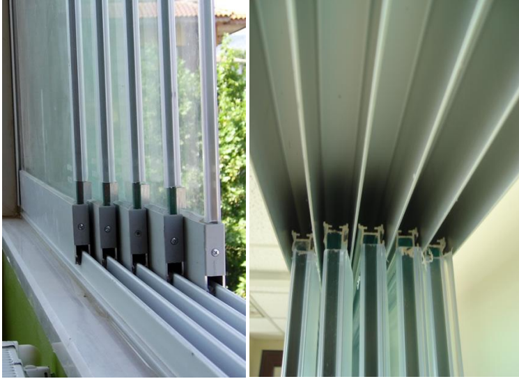
Görsel 339. Sürgülü Cam Balkon Sistemi Alt Ray ve Üst Ray Detayı (Sürme Cam Sistemleri, t.y.)
