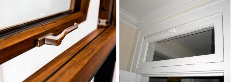
Görsel 138. Pencere Açma Kol ve Mandallarının Pencere Açılış Türüne Göre Konumlanması (Windows, t.y.; Transoms, 2011).
