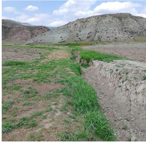
Şekil 4. Drenaj kanallarına ait görünüm (Orijinal: Koç, H.)
