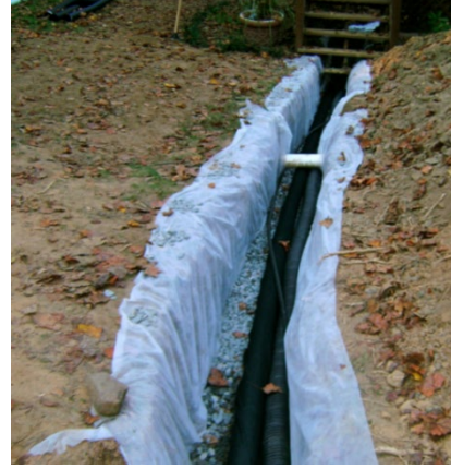
Şekil 2. Yeraltı drenaj sistemleri (Url-2, 2025).
