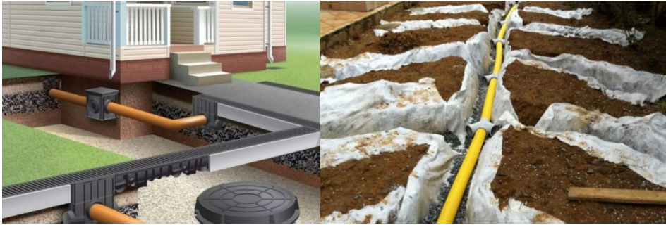
Şekil 3. Yapı drenaj sistemleri (Url-3, 2025).
