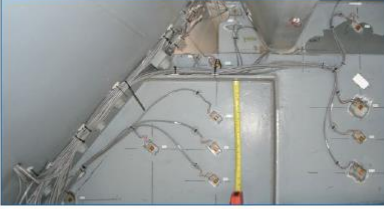
Şekil 2: Köprüdeki yapısal sağlık izleme (Micro measurements, 2021)
