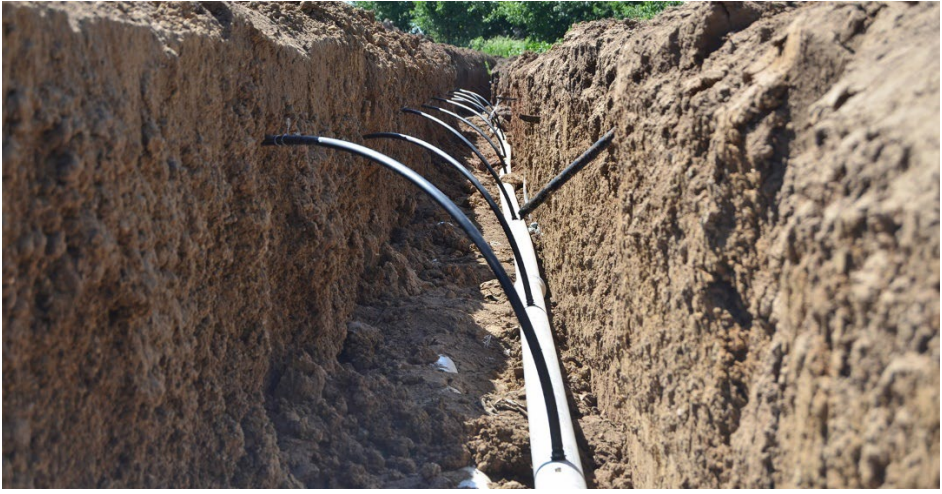
Şekil 8. Yüzey altı damla sulama sistemi (Anonim 2025c)
