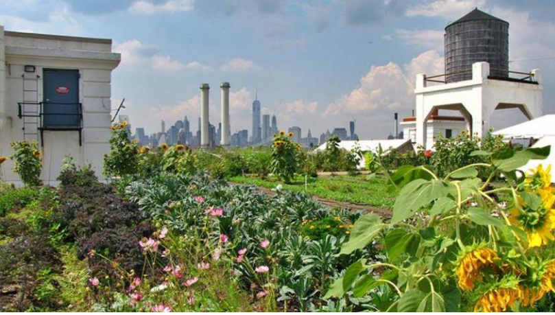
Şekil 1. Çatı bahçesi (Brooklyn Grange LLC 2018)
