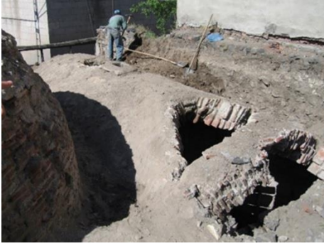
Görsel 33: Gümrük Hamamı Restorasyon Çalışmalarında Tonozları ve Kubbesinin Durumu
