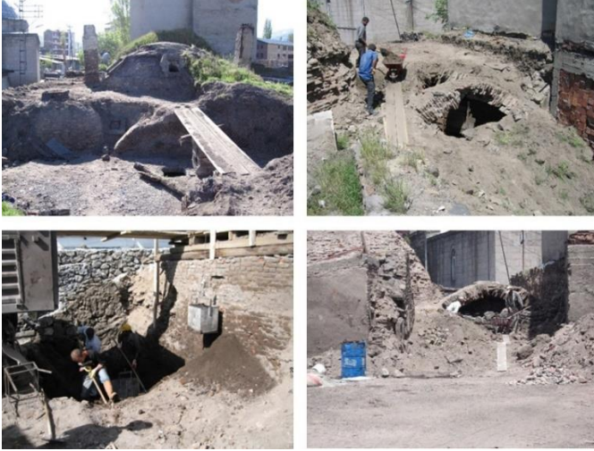
Görsel 32: Gümrük Hamamı Restorasyon Çalışmalarında Kubbe ve Tonozların Boşaltılması
