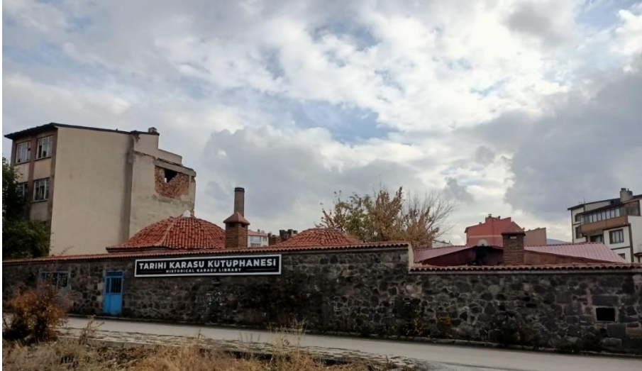
Görsel 36: Gümrük Hamamının Restorasyon Çalışmaları Sonrası Görünümü
