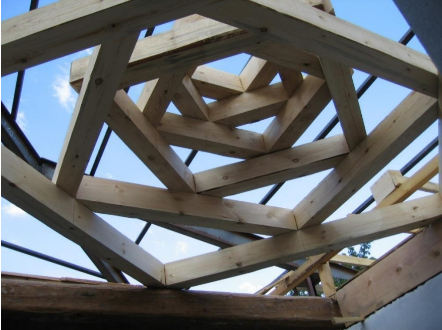
Görsel 26: Gümrük Hanı'nın Ahşap Örtülerinin Restorasyonu
