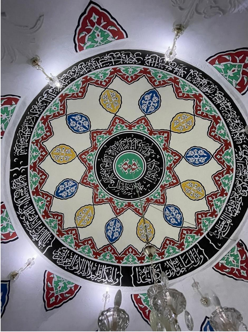
Görsel 13: Şeyh Merzubani Veli Türbesi Kubbesi İçten Görünüm
