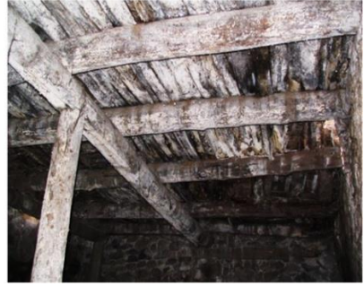
Görsel 23: Gümrük Hanı Odalarının Ahşap Örtülerinin Restorasyon Öncesi Görünümü
