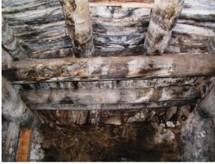
Görsel 23: Gümrük Hanı Odalarının Ahşap Örtülerinin Restorasyon Öncesi Görünümü
