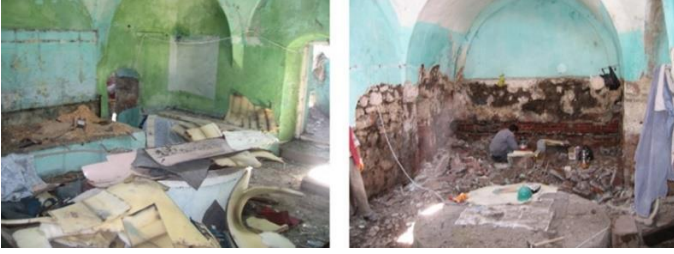
Görsel 31: Gümrük Hamamı Restorasyon Öncesi İçten Görünüşü
