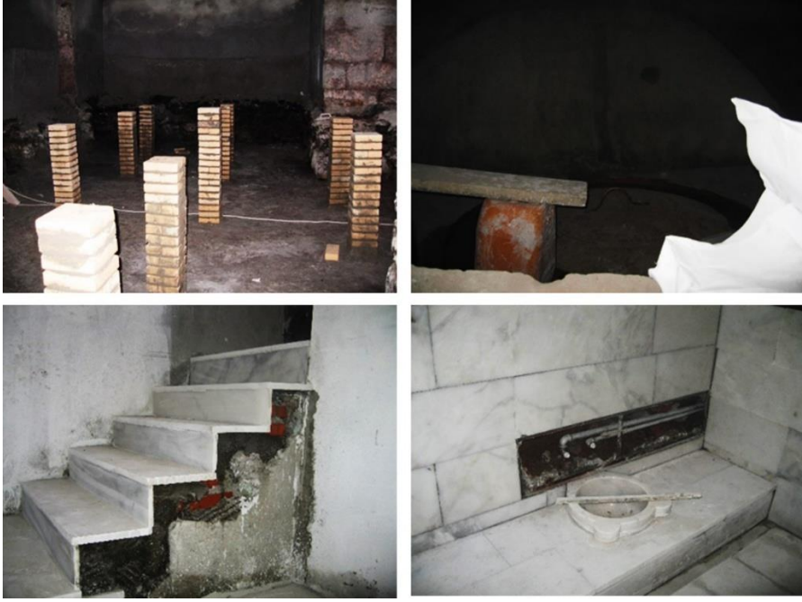
Görsel 35: Hamamın Sıcaklık Bölümü, Değiştirilen Kazanı, Mermer Kaplanan Merdivenler ve Yenilenen Kurnaları
