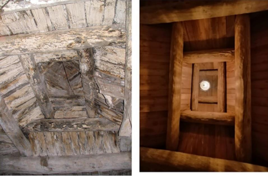
Görsel 27: Gümrük Hanı'nın Ahşap Örtülerinin Restorasyon Öncesi ve Sonrası Görünümü
