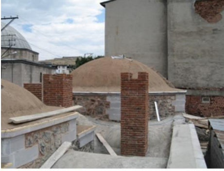
Görsel 33: Gümrük Hamamı Restorasyon Çalışmalarında Tonozları ve Kubbesinin Durumu
