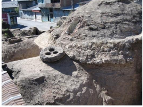
Görsel 33: Gümrük Hamamı Restorasyon Çalışmalarında Tonozları ve Kubbesinin Durumu
