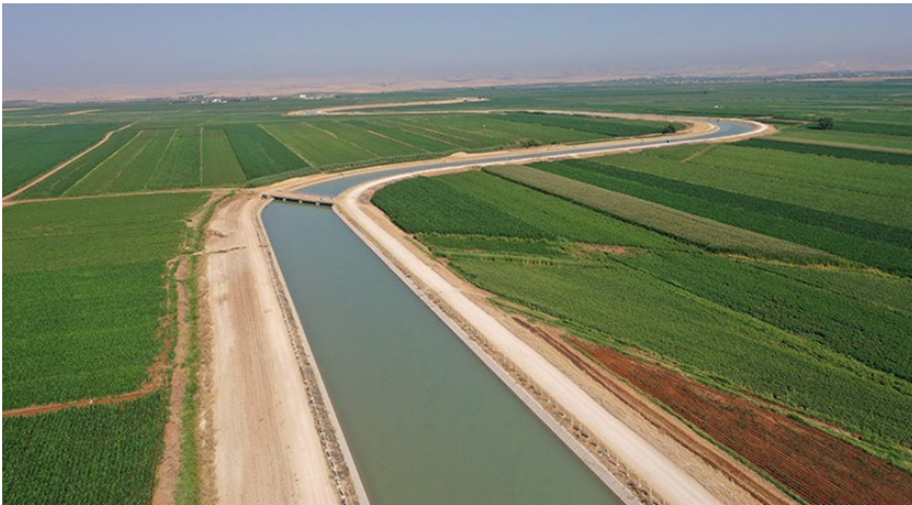
Şekil 3. Atatürk Barajından tüneller ile Harran Ovası ve Mardin Ovalarına Mavi Suyun taşındığı kanal
