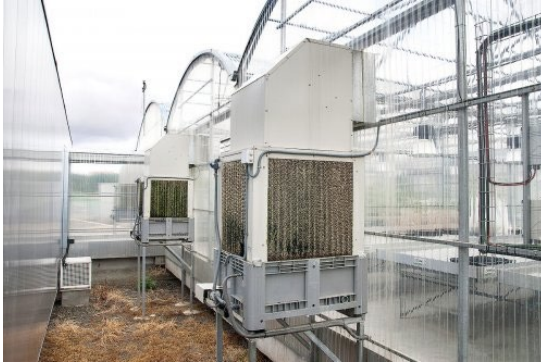
Şekil 9 Sera yanlarına kurulan klima sistemi (Anonim 9 2025)
