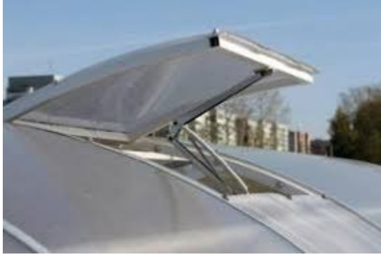
Şekil 2 Polietilen ve polikarbonat seraların çatıdan havalanması (Anonim 2 2025)
