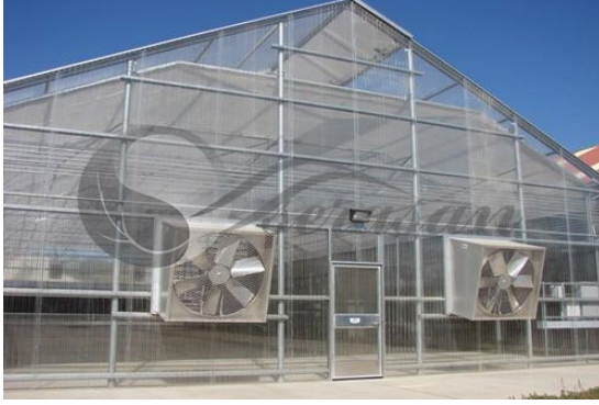
Şekil 8 Sera yanlarına yerleştirilen fan sistemi (Anonim 8 2025)
