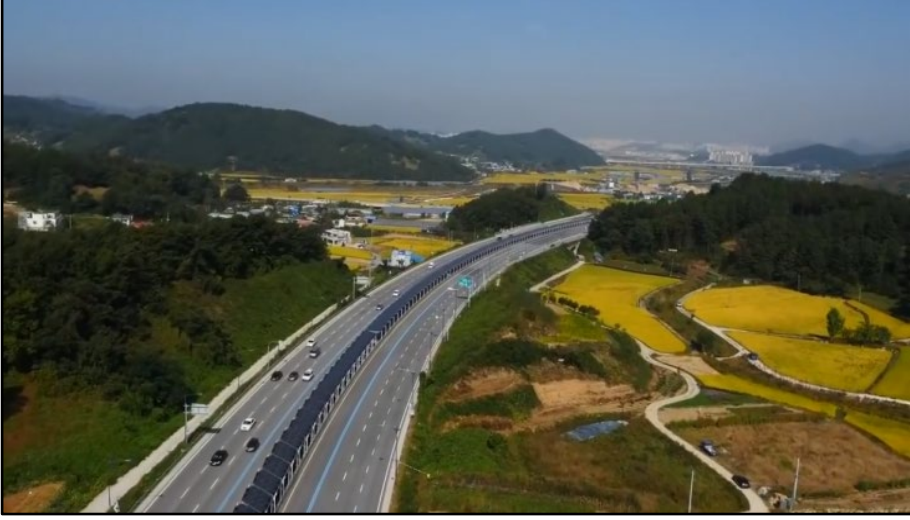
Fotoğraf 6: Güney Kore’de Bisikletli Otoyolun Çatısına Yerleştirilen Güneş Panelleri 38 .
