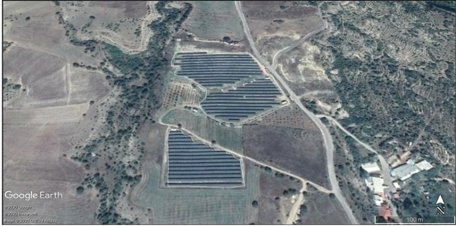
Fotoğraf 32: Kuzyakaköseler Köyünde Tarım Arazilerine Kurulan Güneş Enerjisi Santrali.
