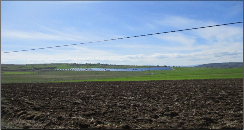
Fotoğraf 31: Bölükören Köyünde Tarım Arazilerine Kurulan Güneş Enerjisi Santrali.
