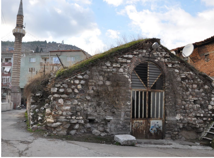
Şekil 2.31: Bedestenin doğu cephesi (Kişisel arşiv, 2017)
