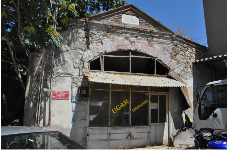
Şekil 2.44: Güneydeki sonradan dükkana dönüştürülen giriş cephesi ve üzerindeki mermer kitabe (Kişisel arşiv, 2017)
