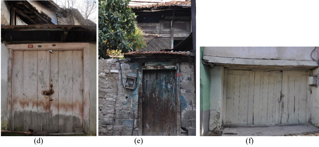
Şekil 4.106: (a), (b), (c) Rum konutlarında görülen bahçe/avlu kapı örnekleri, (d), (e), (f) Türk konutlarında görülen bahçe/avlu kapı örnekleri (Kişisel arşiv, 2019)
