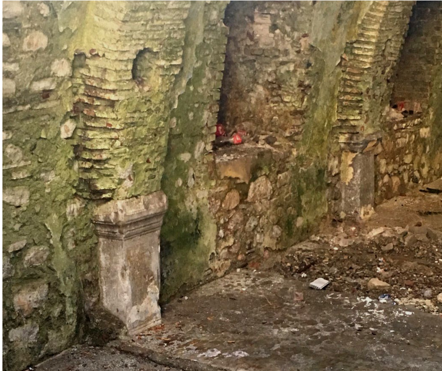
Şekil 2.30: İç mekanda taşıyıcı kemerlerin altındaki Antik Dönem taşları (Kişisel arşiv, 2017)
