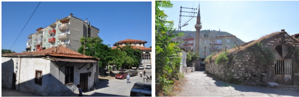
Şekil 5.16: Çarşı Camii'nin yanında (eski Çukur Han'ın yerinde) inşa edilmiş, dokunun her yerinden göze çarpan ve silüeti olumsuz etkileyen 5 katlı apartman yapısı (Kişisel arşiv, 2019)
