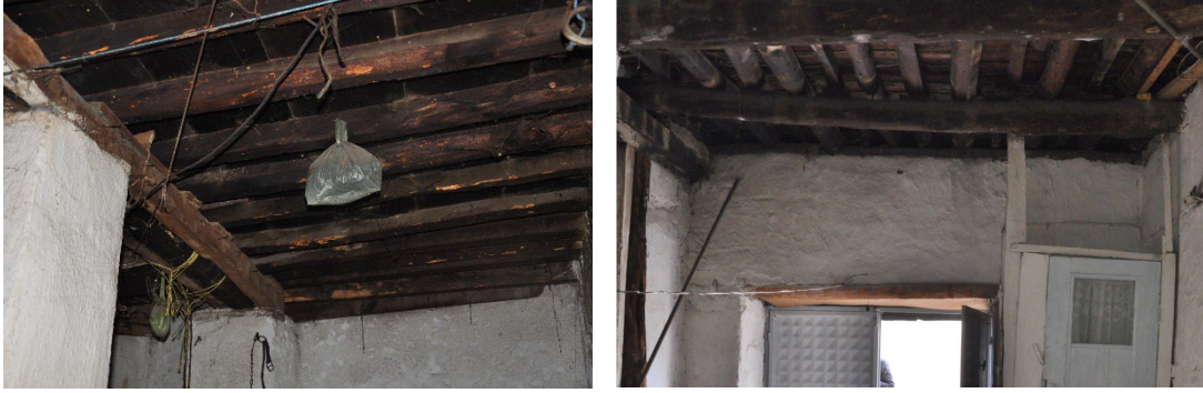
Şekil 4.101: Ahşap kirişli döşeme örnekleri (Kişisel arşiv, 2019)
