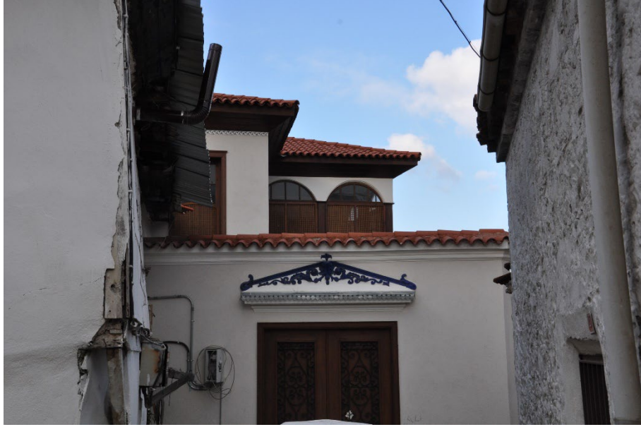
Şekil 4.53: Yapının Dokuz Oluk Çeşmesi karşısındaki ara sokakta bulunan bahçe kapısı (Kişisel arşiv, 2019)
