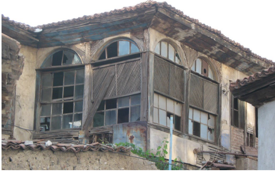
Şekil 4.55: Yapının restore edilmeden önceki resmi (Soma Belediyesi arşivi)
