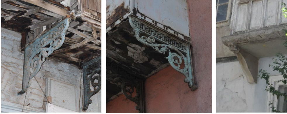
Şekil 4.122: Rum konutlarındaki cumbalarda görülen dökme demir payanda örnekleri (Kişisel arşiv, 2018)
