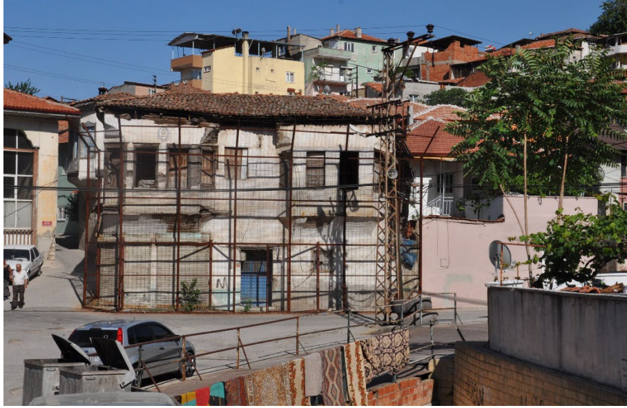
Şekil 5.18: Tarihi yapı arkasında kalan, silüeti olumsuz etkileyen, izinsiz inşa edilmiş yapı örnekleri (Kişisel arşiv, 2019)
