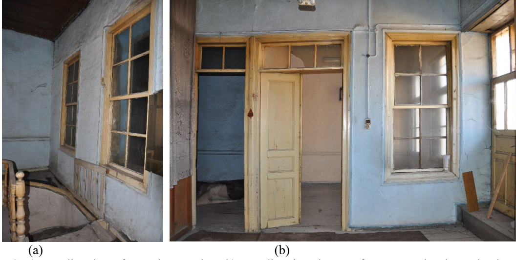
Şekil 4.76: a) Merdivenin sofaya çıktığı nokta, b) Merdivenin çıktığı sofanın sonradan kapatılarak Oda 1' e çevrildiği mekan (Kişisel arşiv, 2019)
