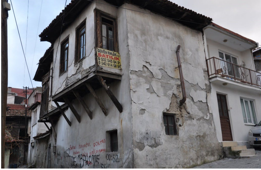
Şekil 4.24: Konutun ön cephesi (güney) ile doğu cephesinden bir görünümü (Kişisel arşiv, 2019)
