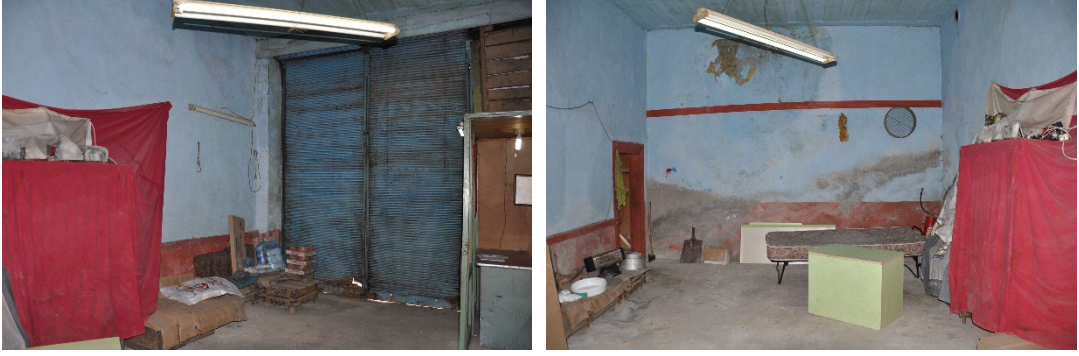
Şekil 4.71: Yapının ön cephesinde, sağda bulunan dükkan (Kişisel arşiv, 2019)
