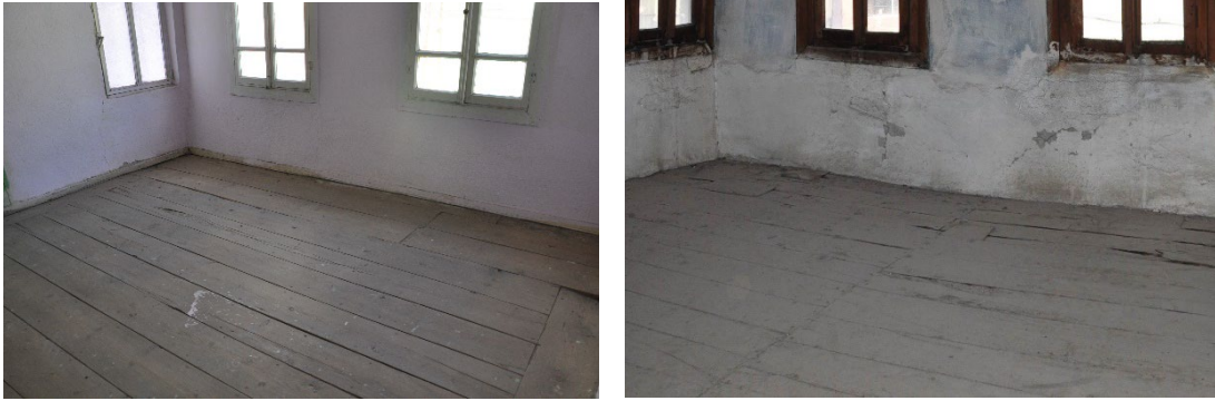
Şekil 4.102: Ahşap kirişlemenin üzerine kaplanmış ahşap döşeme resimleri (Kişisel arşiv, 2019)
