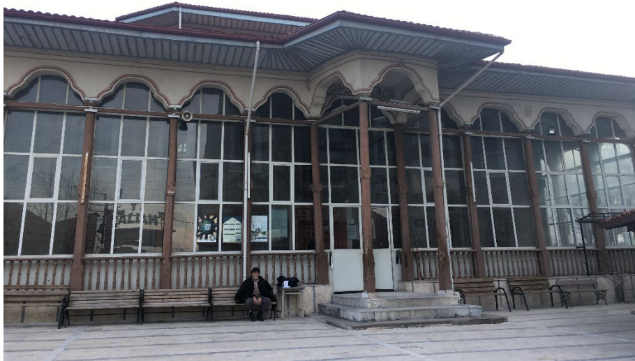
Şekil 2.12: Caminin giriş (kuzey) cephesinden görünümü (Kişisel arşiv, 2017)
