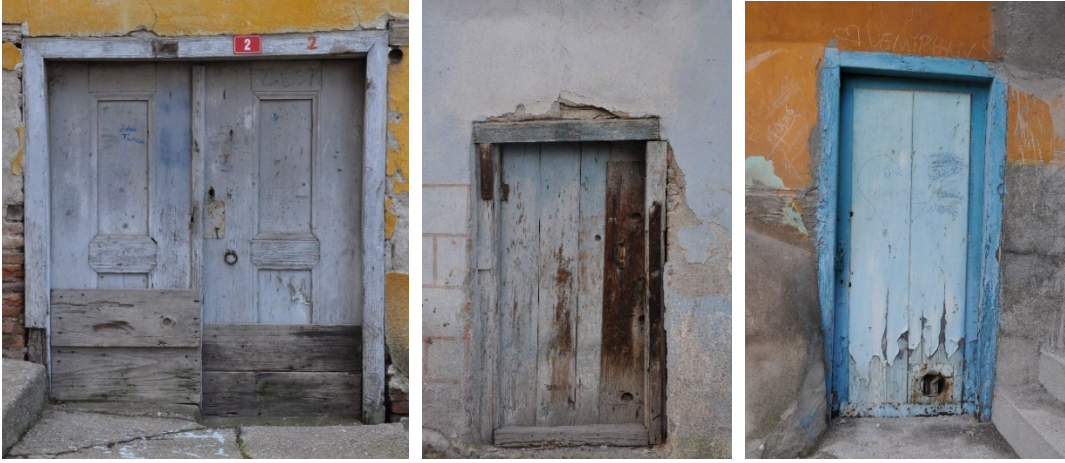
Şekil 4.114: Türk konutlarında görülen ahşap kapı ve pencere söveleri (Kişisel arşiv, 2019)
