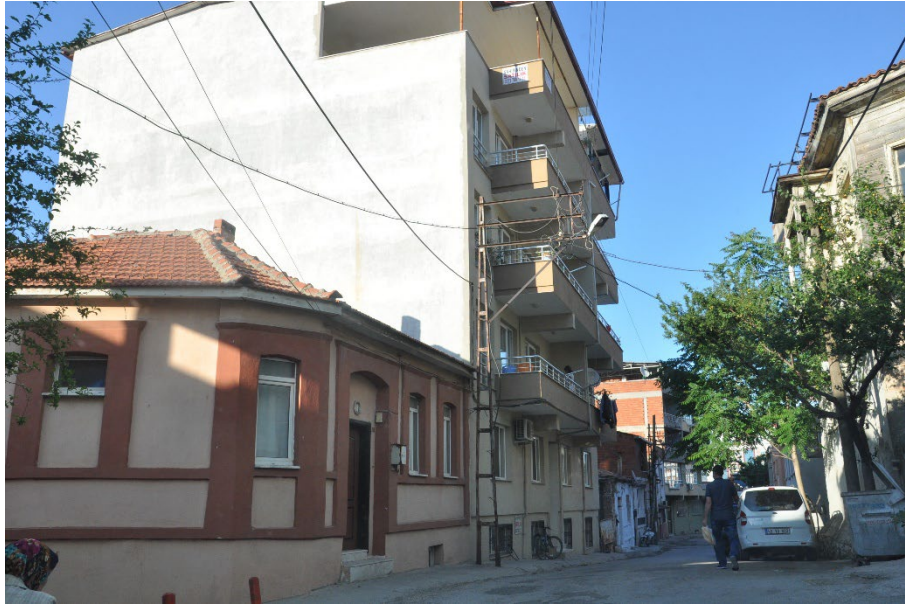
Şekil 5.15: Bodrum + 1 katlı tarihi yapının yanında inşa edilen 5 katlı apartman yapısı (Kişisel arşiv, 2019)
