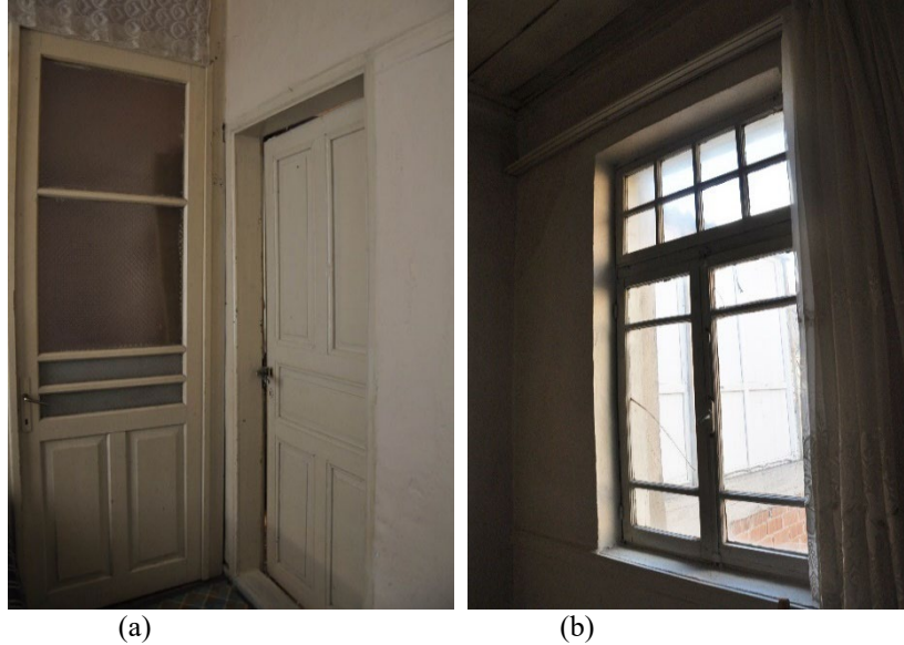
Şekil 4.91: a) Üst kat sofasında bulunan kapılar (soldaki kapı dönem eki olan odanın, sağdaki kapı 3 numaralı oda kapısının resmidir), b) Yapıdaki ahşap çift kanatlı pencere örneği (Kişisel arşiv, 2019)
