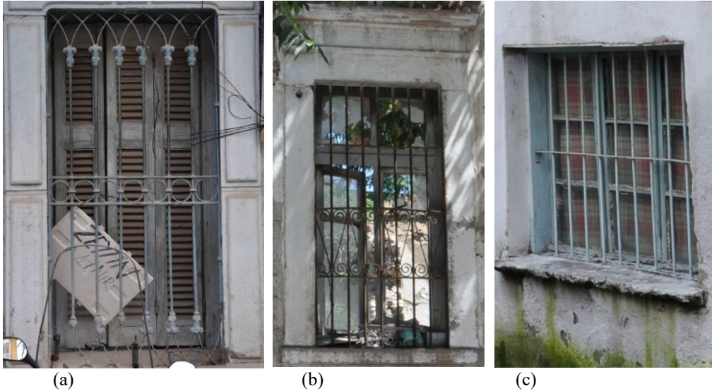
Şekil 4.115: a) Rum konutlarında nadiren görülen özgün demir parmaklık örneği, b), c) Sonradan takılan demir parmaklık örnekleri (Kişisel arşiv, 2019)
