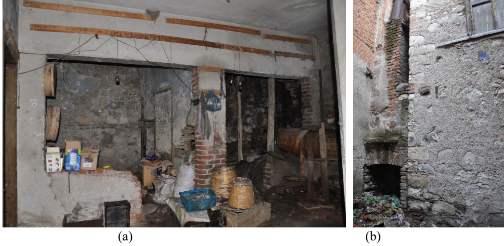
Şekil 4.74: a) Bahçe çıkış kapısının solunda bulunan sonradan yapılmış niteliksiz oda ekleri, b) Yüksek bahçe duvarlarından birinde bulunan tuğla ocak (Kişisel arşiv, 2019)
