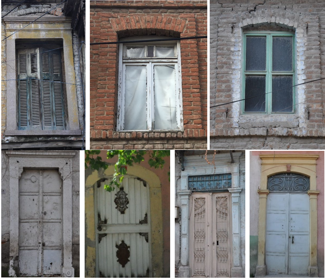
Şekil 4.113: Rum konutlarında görülen taş ve tuğla kapı, pencere söveleri (Kişisel arşiv, 2019)
