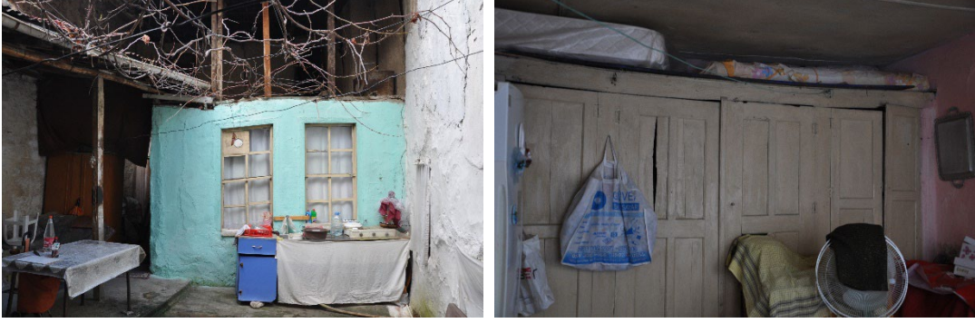
Şekil 4.44: Avluda bulunan 1 numaralı odanın dışarıdan ve içeriden görünümü (Kişisel arşiv, 2019)
