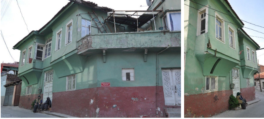
Şekil 4.5: Konutun Fevzi Çakmak Caddesi ile Karcılar Sokak birleşiminde bulunan ön cephesi (Kişisel arşiv, 2019)
