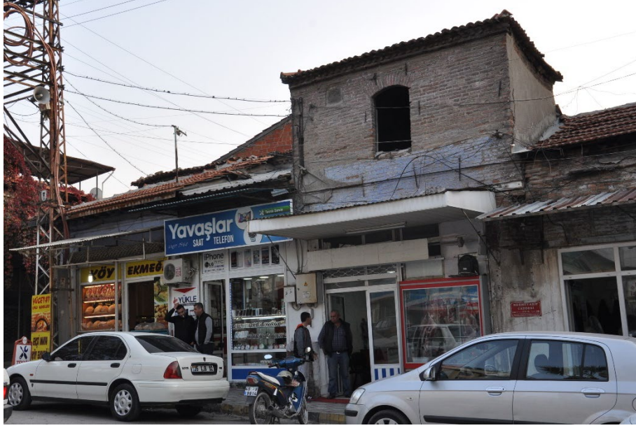
Şekil 5.2: Yapı cephelerinin niteliksiz eklerle kapatılması sonucu tarihi dokusu anlaşılmayan dükkan örnekleri (Kişisel arşiv, 2019)
