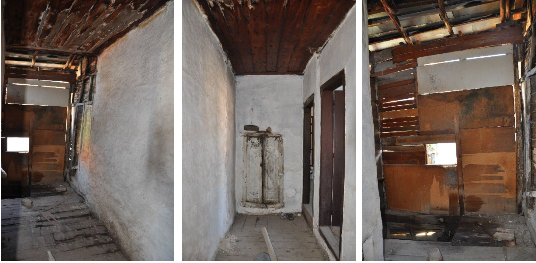
Şekil 4.31: L biçiminde olan dış sofanın sağır ve kapatılmış bölümleri (Kişisel arşiv, 2019)
