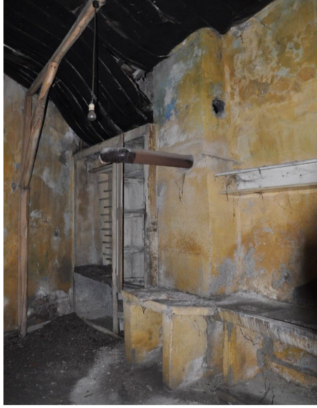
Şekil 4.82: Sonradan yapılan üst kattaki mutfak mekanı (Kişisel arşiv, 2019)
