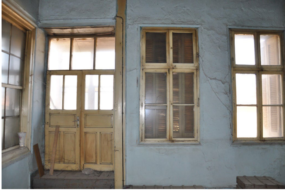
Şekil 4.78: Oda 1' deki ön cepheye bakan pencereler ve cumba çıkış kapısı (Kişisel arşiv, 2019)
