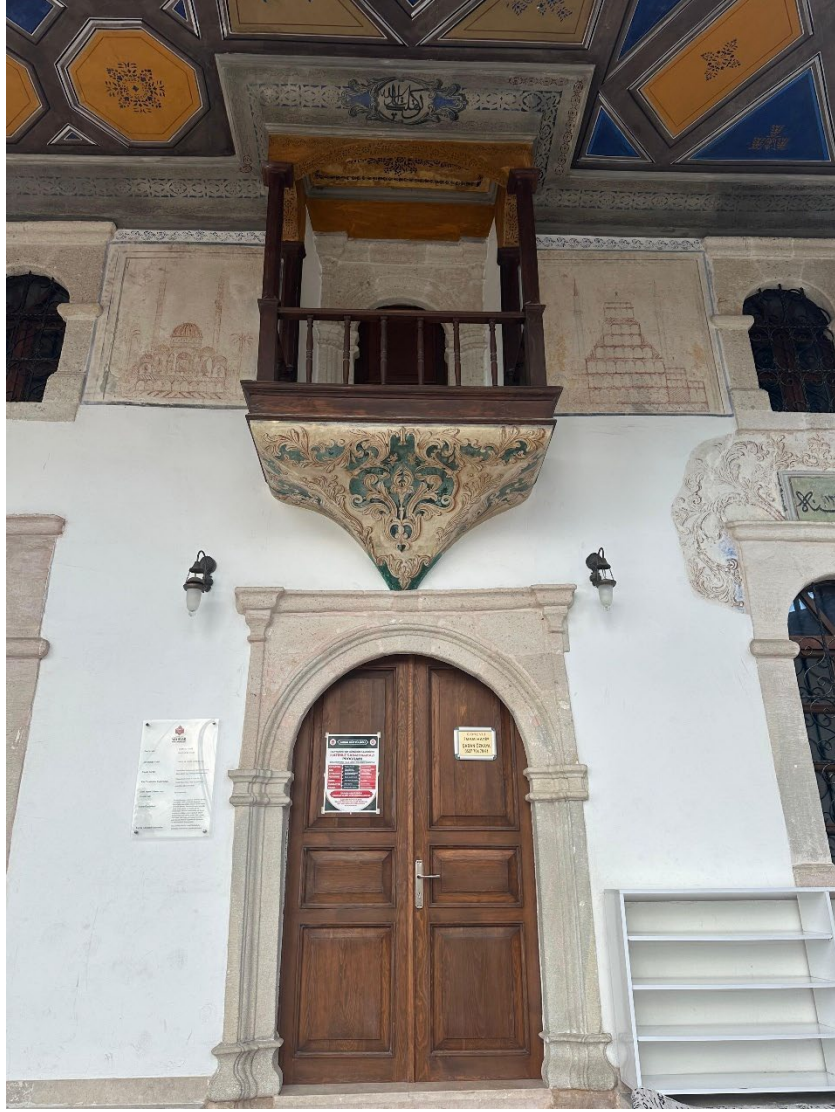
Şekil 2.21: Son cemaat yerindeki tavan, altı kalemişli mükebbire ve giriş kapısı detayı (Kişisel arşiv, 2025)
