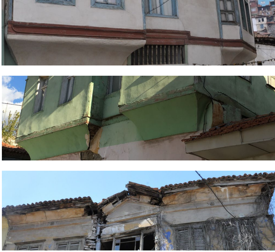
Şekil 4.112: Türk konutlarında görülen ahşap silmeler (Kişisel arşiv, 2019)
