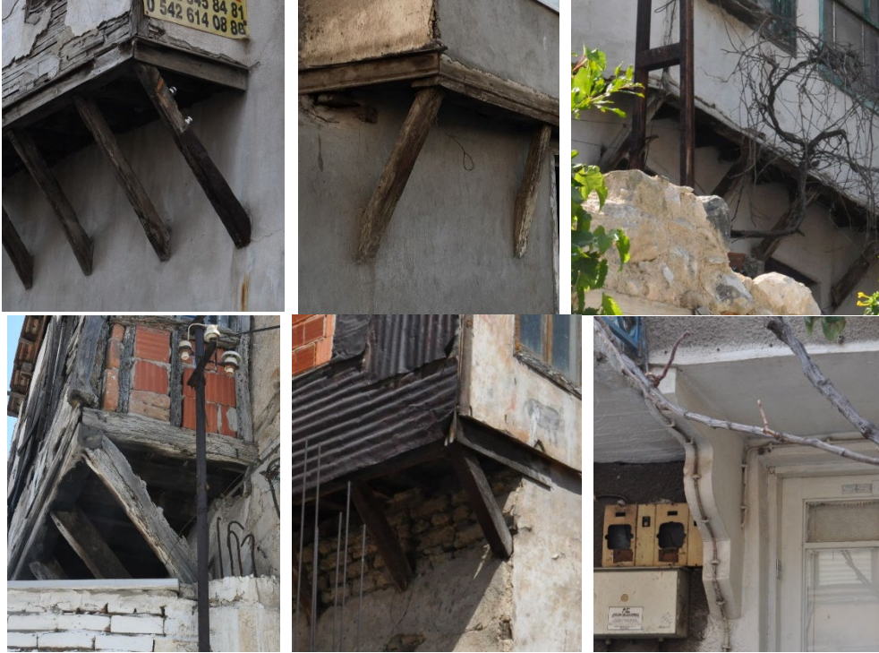
Şekil 4.123: Türk konutlarındaki çıkmalarda görülen eli böğründe örnekleri (Kişisel arşiv, 2019)
