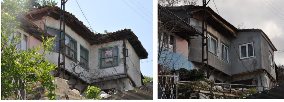
Şekil 5.6: a) Dokuda bulunan geleneksel bir yapının 'satılık' durumundaki özgün hali (Kişisel arşiv, 2017), b) Yapının satın alındıktan sonraki 'onarılmış' hali (Kişisel arşiv, 2019)
