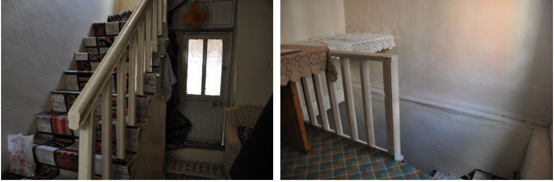
Şekil 4.88: Evin batı duvarında yer alan ahşap merdiven (Kişisel arşiv, 2019)
