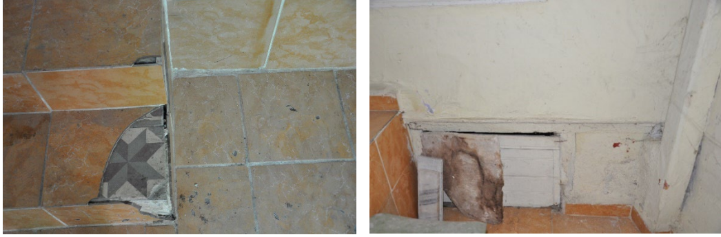
Şekil 4.10: Yapının girişinde görülen karo döşeme ile bodrum kapısı (Kişisel arşiv, 2019)
