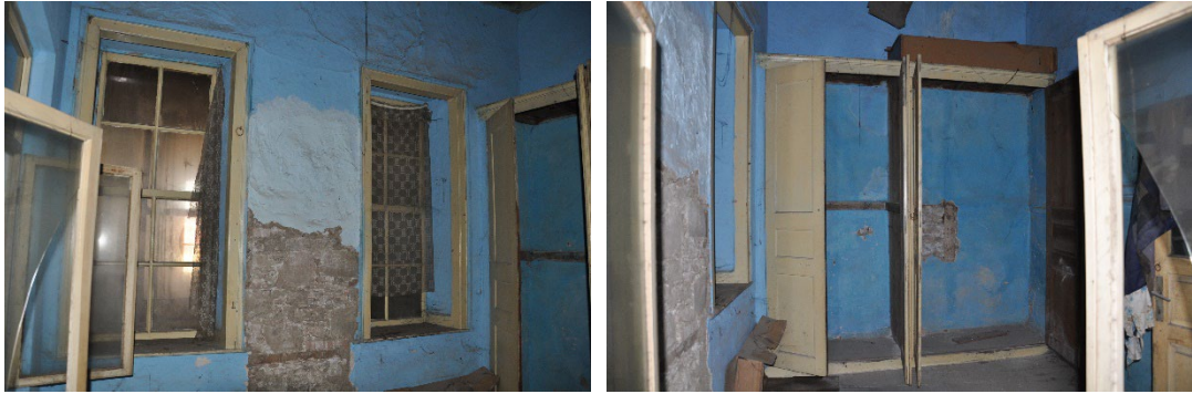
Şekil 4.81: 4 numaralı odanın ahşap giyotin iç pencereleri ve ahşap dolapları (Kişisel arşiv, 2019)
