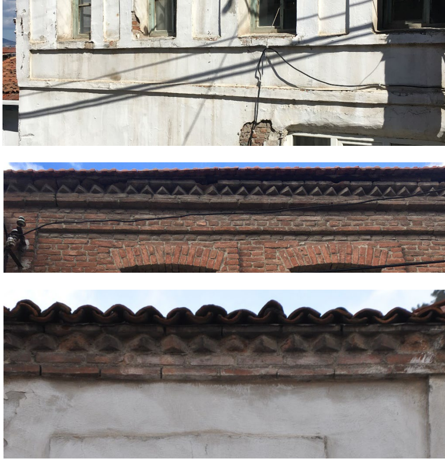
Şekil 4.111: Rum konutlarında görülen saçak ve ara kat silmeleri (Kişisel arşiv, 2019)
