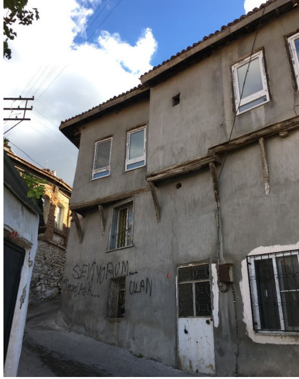
Şekil 5.4: Yapıda, özgünde olmayan kapı ve pencere açıklıklarının oluşturulduğu bir örnek (Kişisel arşiv, 2018)
