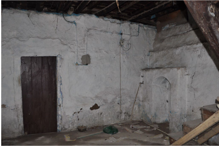
Şekil 4.28: Zemin kattaki giriş mekanın resmi (Kişisel arşiv, 2019)
