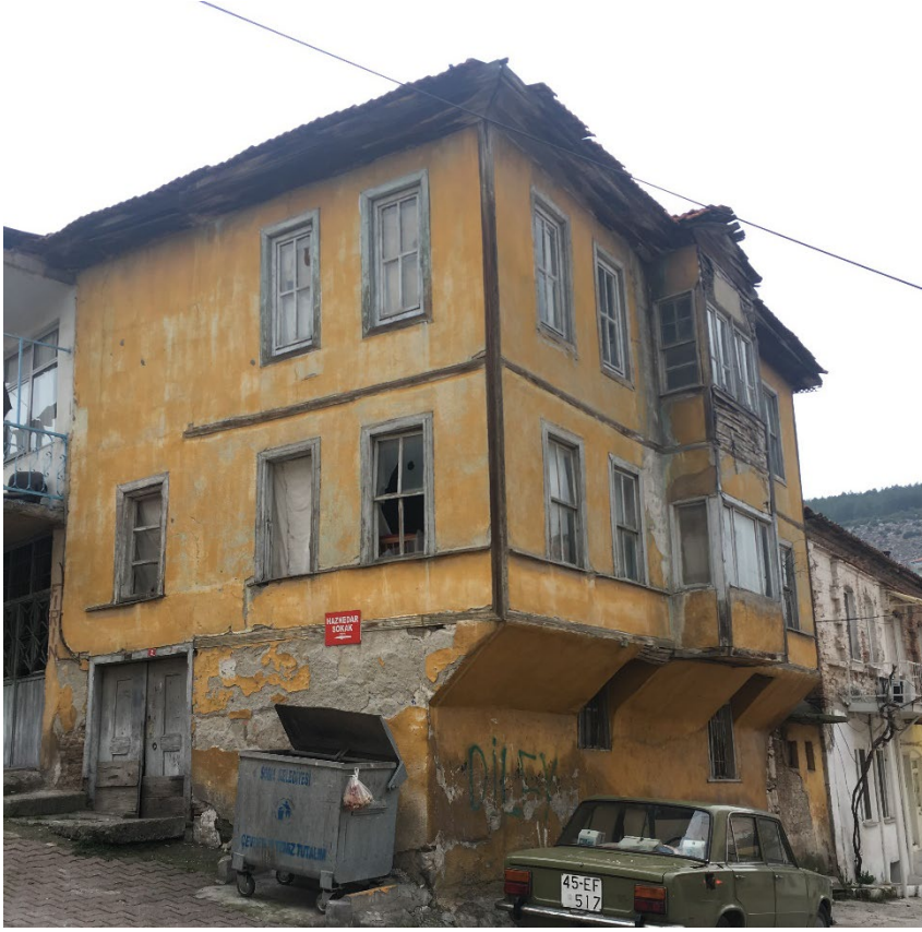
Şekil 3.14: 203 Ada 9 Parseldeki özgünlüğü korunmuş tescilli yapı (Kişisel arşiv, 2019)
