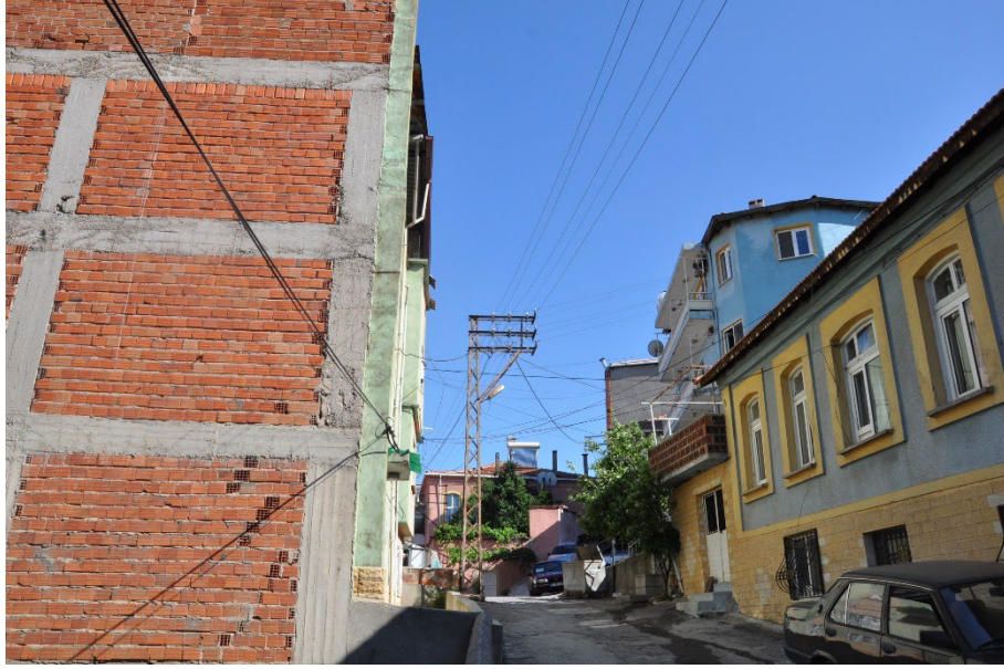
Şekil 5.19: Tarihi dokuda bilinçsizce inşa edilen yapı boyutları geleneksel yapıların ezilmesine neden olmaktadır (Kişisel arşiv, 2019)
