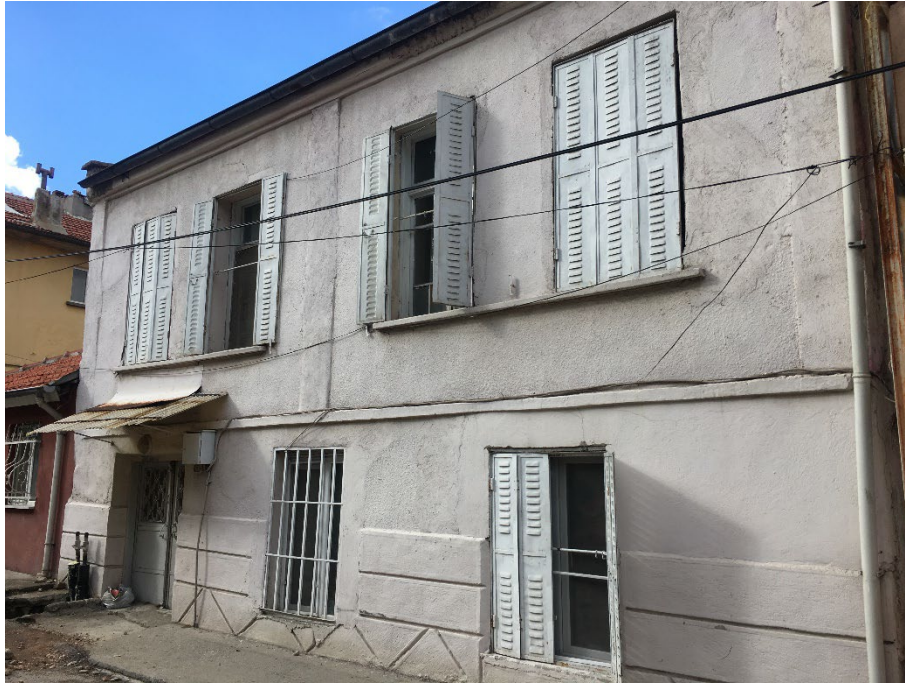
Şekil 4.84: Yeşil Tuna Sokak üzerinde yer alan konutun ön cephesi (Kişisel arşiv, 2019)
